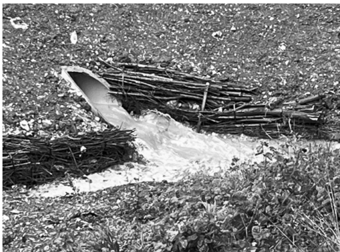
Wasseraustritt Ableitung Simmen in Weidbach bei Regen
