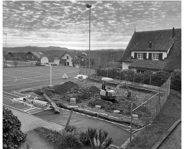
Aushub und Fundament
