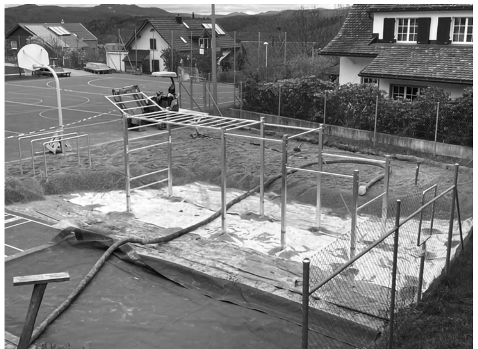
Kurz vor Fertigstellung
