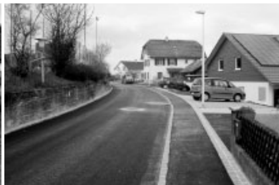
Baufortschritt Bifangstrasse (Mauer Höhe Schulhaus)
