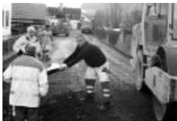
Verdichtung Strassenkofferrung
