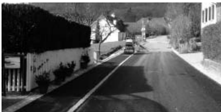
Fehlt nur noch der Deckbelag und die Einfärbung des Gehweg's
