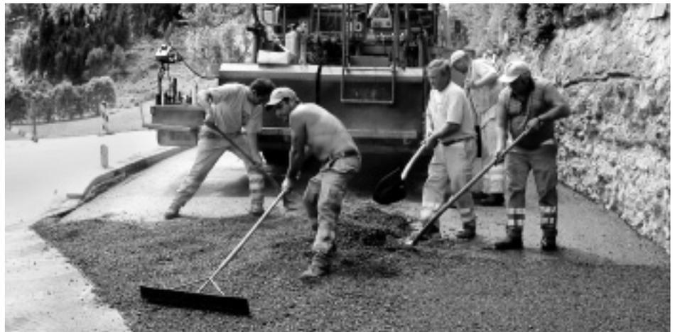
Nach eingehender Beratung durch verschiedene Fachleute kamen wir zum Schluss, dass die einfachste, schnellste, günstigste und dauerhafteste Lösung das Aufbringen eines 5 cm starken Belages als Hocheinbau ist.
