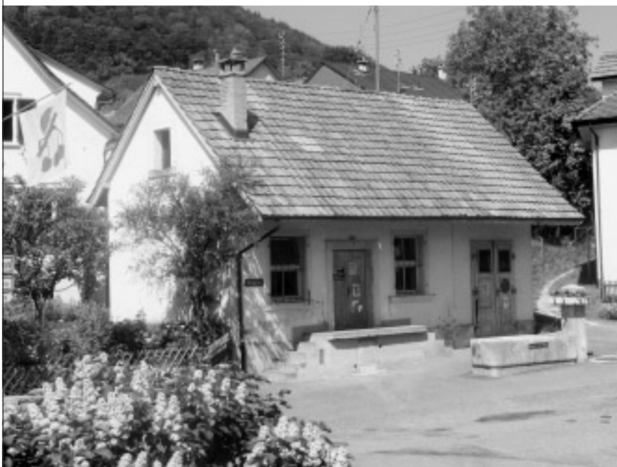
Die gute Rechnung 2003 wird es möglich machen, die in den letzten Jahren hinausgeschobenen, aber dringend notwendigen Investitionen (z.B. Sanierung Milchhüsli) im Jahr 2005 endlich aufzugleisen.
