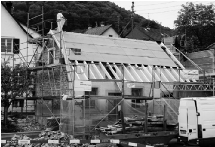
Das Milchhüsli im April. Die Arbeiten sind bald ganz abgeschlossen ...
