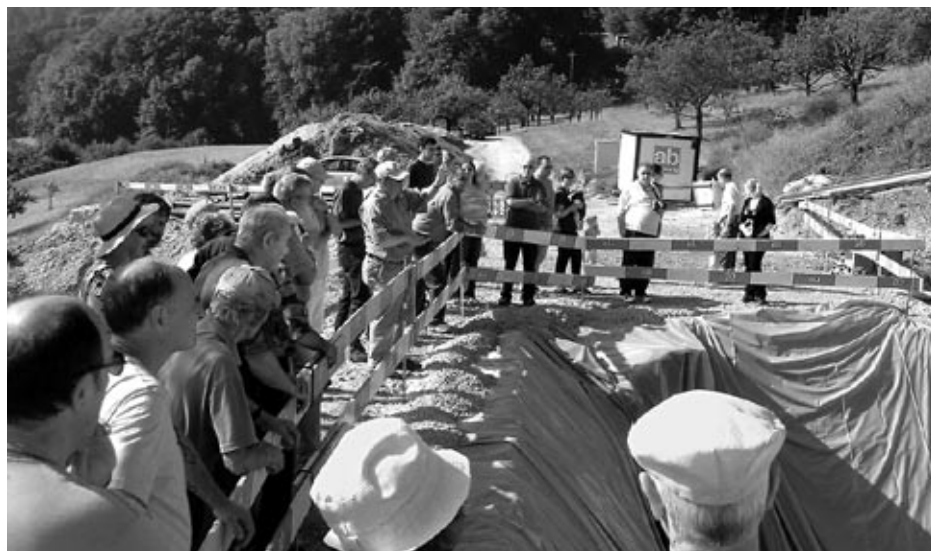
Wände und Decke des neuen Reservoirs Schwarzacker sind bereits betoniert – rund 100 Einwohnerinnen und Einwohner besuchten am 30. August die Baustelle.
