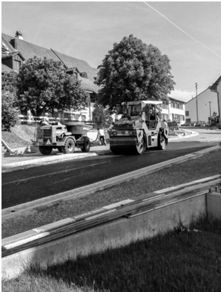
Einbau des Deckbelages
