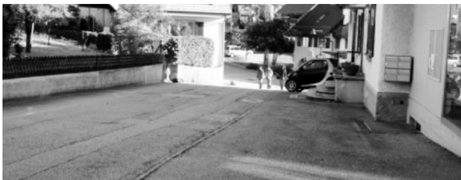
Auf dieser Höhe werden Sanierung und Umbau der Bifang/St. Pantaleonstrasse gestartet
