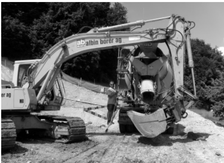
Beton wird ins neu entstehende Reservoir Schwarzacker eingebracht.
