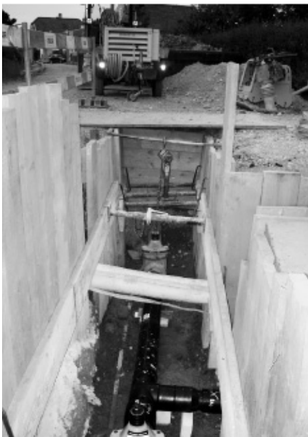
... und die Wasserleitung mit Schieber montiert.
