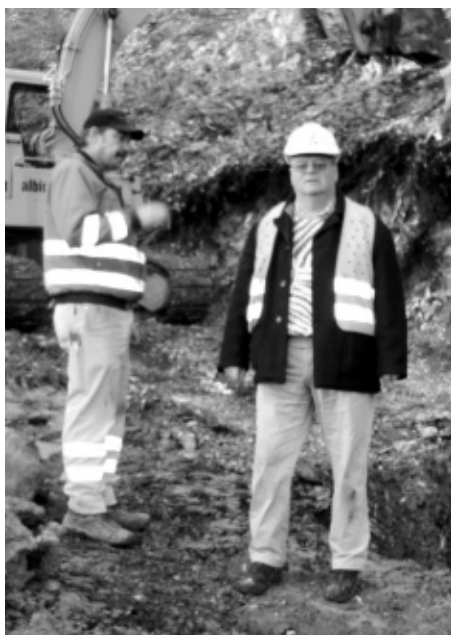
Georg Hofmeier war täglich auf der Baustelle.
