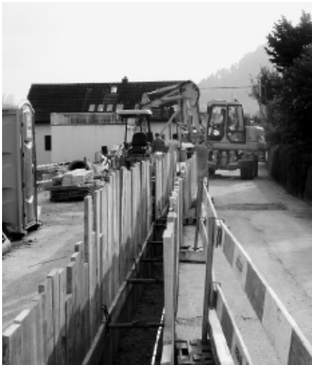
Der Wasserleitungsgraben wird gebaut...
