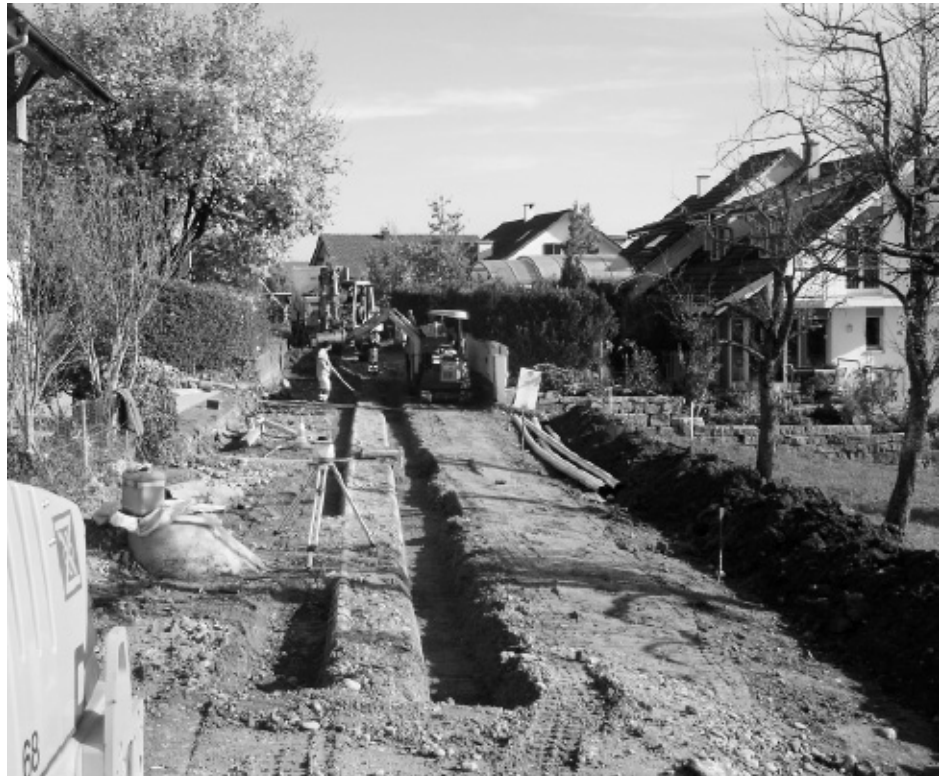
Bifangstrasse Etappe 2 im Bau
