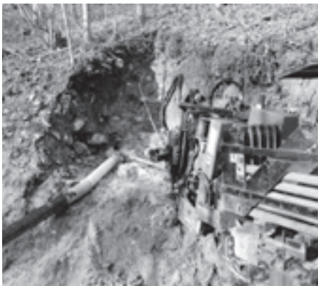
Bohrarbeiten im Oristal, welche Richtung Drissetstrasse voran getrieben werden.
