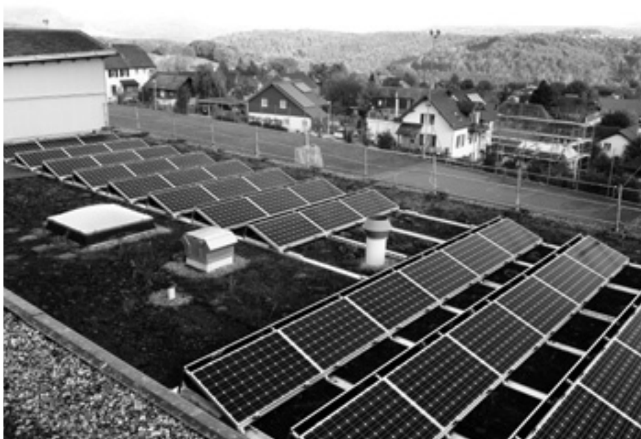
214 Megasol-Elemente sind auf den Dächern der MZH und des Schulhauses montiert.
