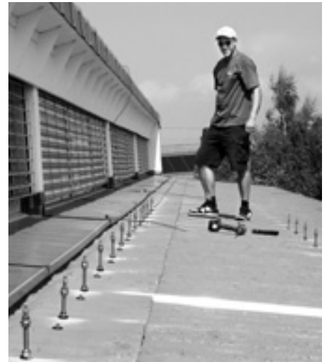
Das Schulhausdach wird zum Kraftwerk – hier werden Solarpanels montiert, die 46 000 kWh Strom liefern.
