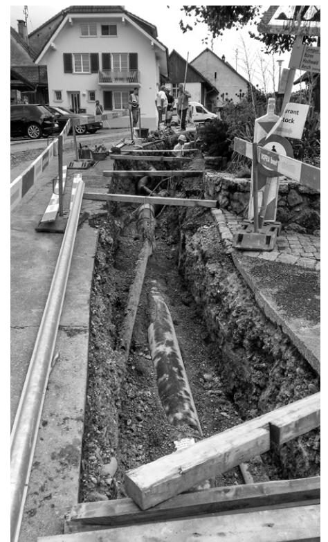
Neue Wasser- und Kanalisationsleitung.
