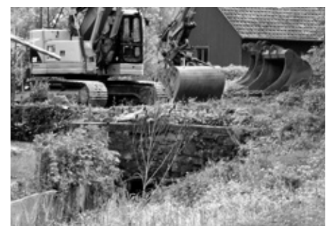
In nur wenigen Wochen wäre der neue Durchlass gebaut gewesen
