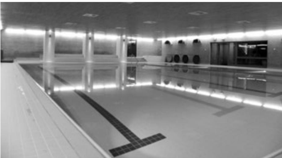
richtet. Die undichten Bodenbeläge sind entfernt und erneuert worden. Leitungen und Lüftungskanäle im Deckenbereich wurden im Rahmen der technischen Erneuerung ersetzt und mit einer schallabsorbierenden Holzdecke verkleidet.
