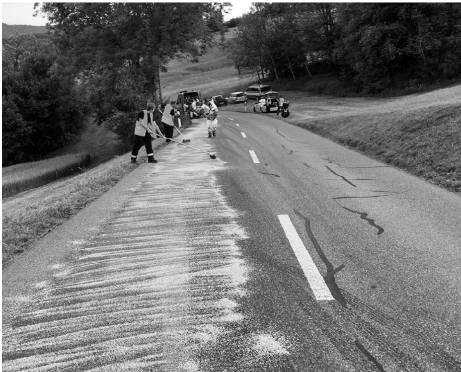
Die Ölspur wird mittels Bindemittel aufgenommen
