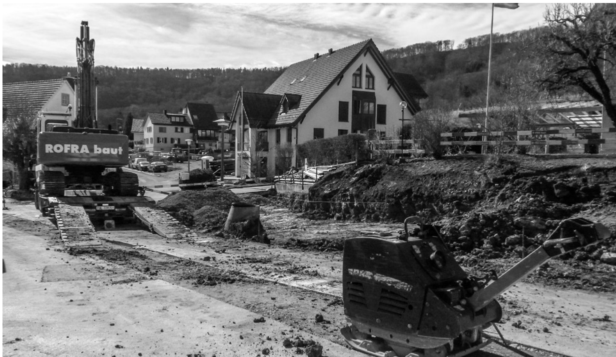
Die Bauarbeiten schreiten voran
