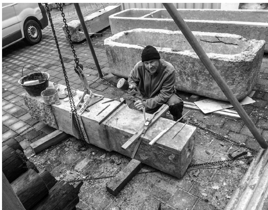
Sanierung des Ausserdorf-Brunnens
