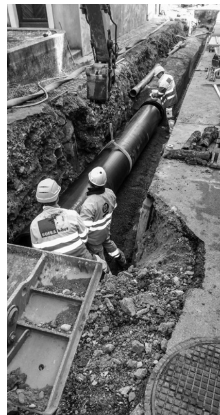
Einbau der Kanalisationsleitung
